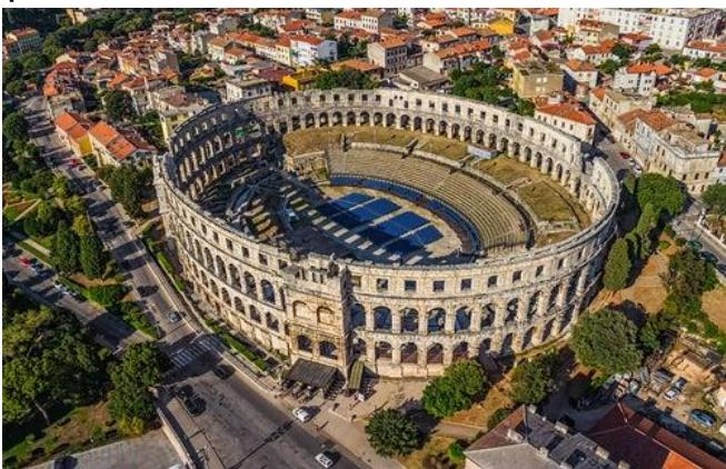
Levantado junto al mar, los muros exteriores están hechos de sillares regulares de piedra caliza. La fachada que da hacia el mar tiene tres pisos y una altura máxima que ronda los 30 m, mientras que el resto de su perímetro tan solo tiene dos alturas porque aprovecha el desnivel del terreno. Los dos primeros niveles presentan 72 arcos de medio punto cada uno, mientras que el último cuenta con 64 arcos adintelados.
